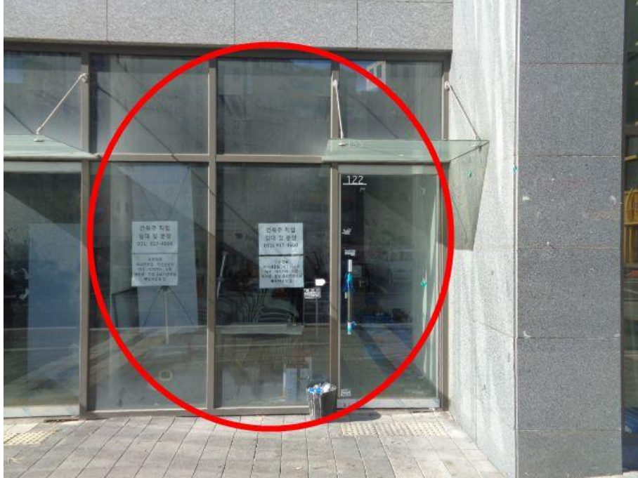
본건 전경(일련번호(아) - 122호)
