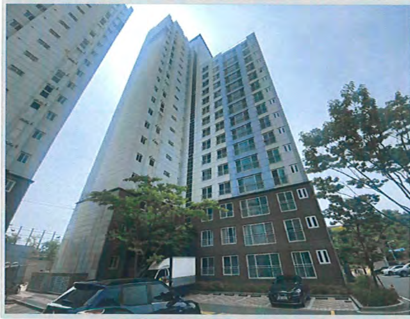
【본건 전체 전경(104동)】
