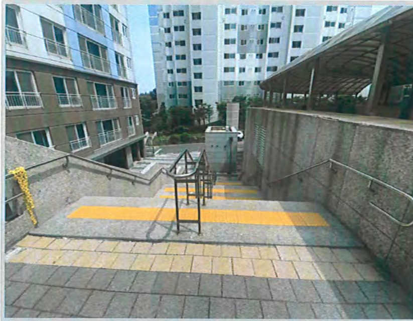
【본건 단지내 전경】
